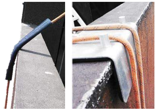
切断防止措置の例 (置き型養生) ▲
